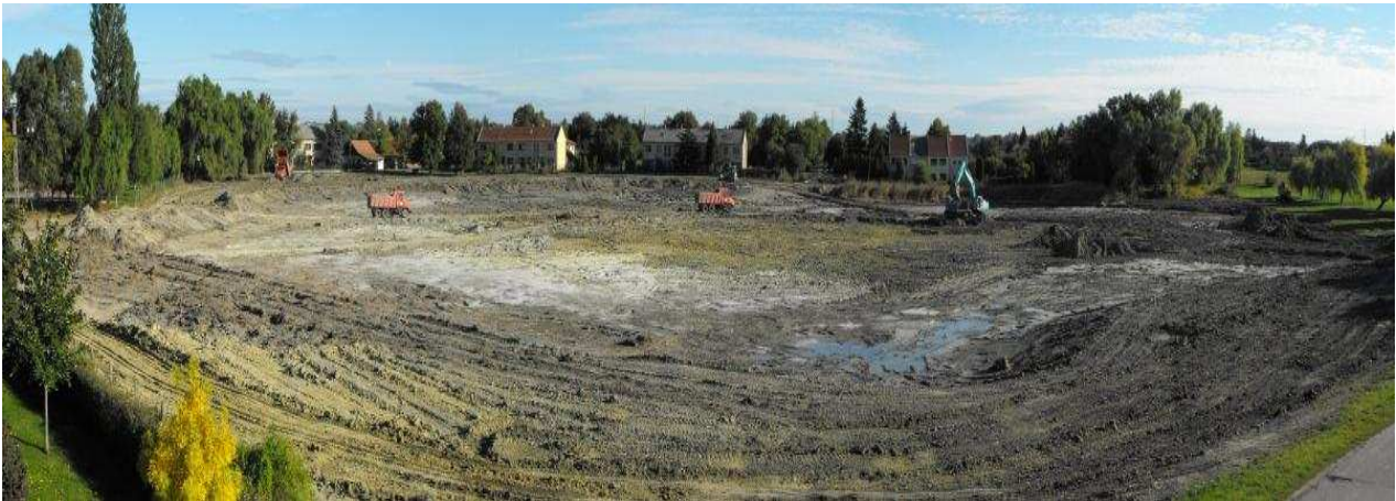
1. Kép: Tó kotrási munkálatai
